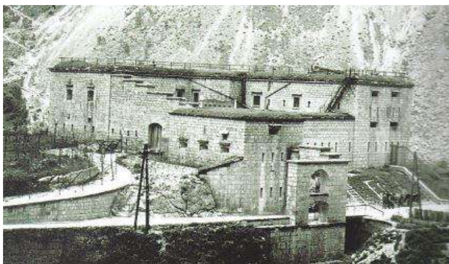
Pogled na utrdbo v Klužah s ceste Bovec- Log pod Mangartom leta 1915 .Ob stražnici je kamniti portal z vrati, desno od njega pa jarek, premoščen z mostom. Portal so po 2. svet. Vojni odstranili. Vir: Simić, M.: Utrdbi pod Rombonom
